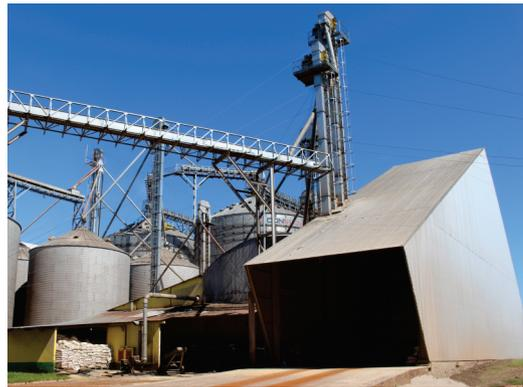
Na Unidade Industrial de Rações de Entre Rios do Oeste foi instalado um tombador e construído um armazém com capacidade para 3.000 toneladas de farelo.
