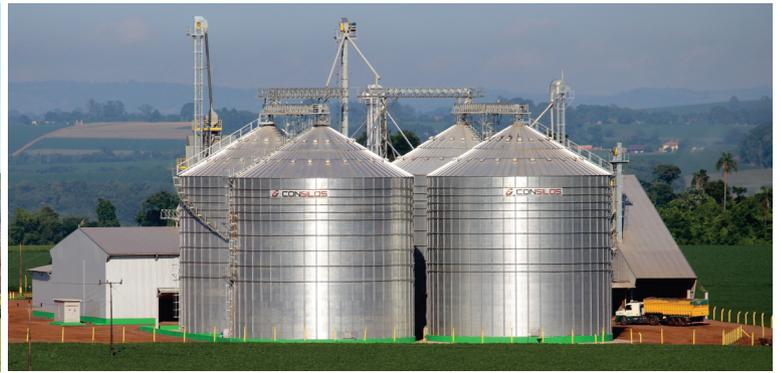
A unidade de recebimento de grãos de Margarida, distrito de Marechal Cândido Rondon-PR, foi ampliada. Foram instalados quatro silos, duas máquinas de pré-limpeza e limpeza, secador, tombador e balança. Agora a capacidade de armazenamento é de 28.080 toneladas de grãos.
